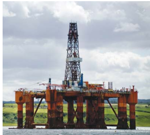
Une tour de forage.
